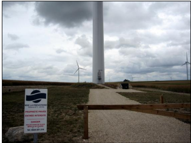
Photo 51 : Pied d'une éolienne déjà construite du parc de la Prévoterie (Aube).
