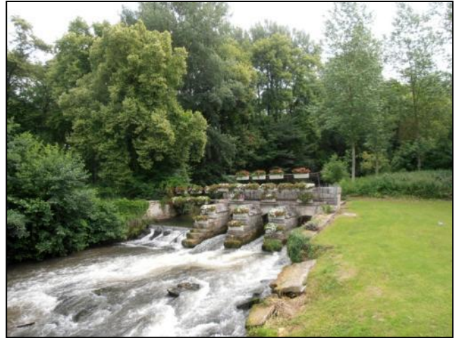
Photo 9 : Un barrage sur la Vesle.
