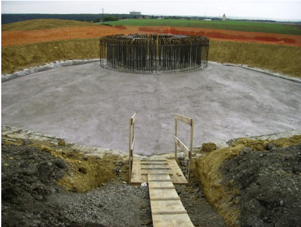
Photo 44 : Fondation d'une éolienne (Source : Maïa Eolis).
