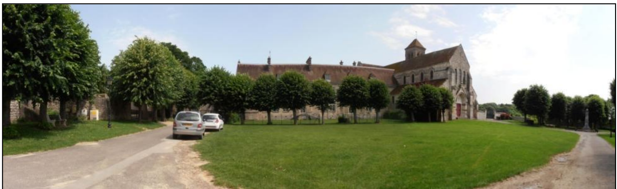
Photo 36 : Les abords de l'église d'Oulchy-le-Château.
