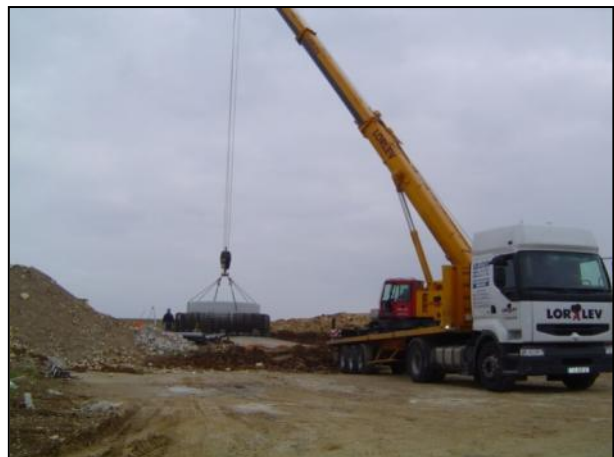
Photo 1 : Piste d'accès temporaire (Source : Maïa Eolis).
