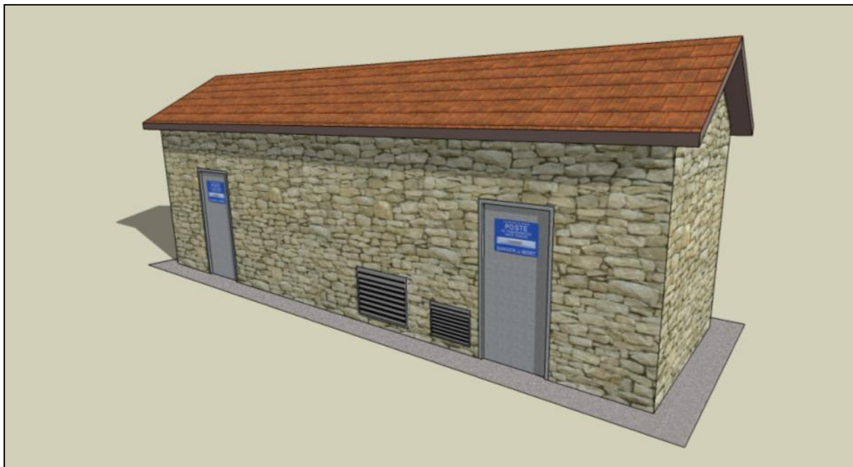
Figure 57 : Exemple de parement en pierre de taille pour le poste de livraison (photomontage).
