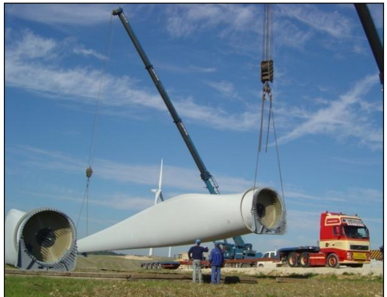
Photo 2 : Montage des pales (Source : Maïa Eolis).
