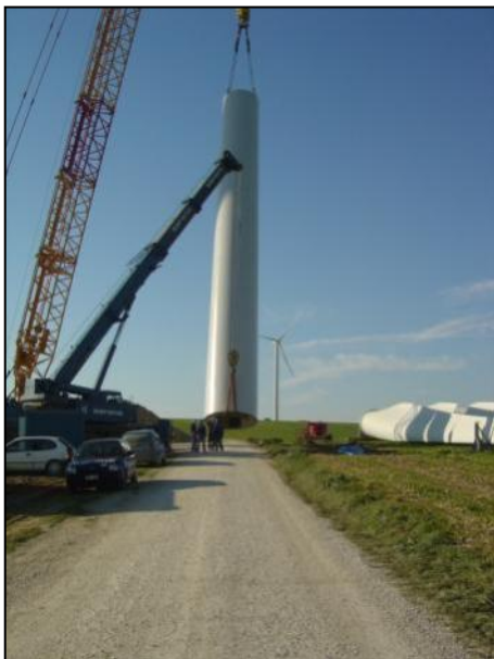
Photo 3 : Montage du mât (Source : Maïa Eolis).
