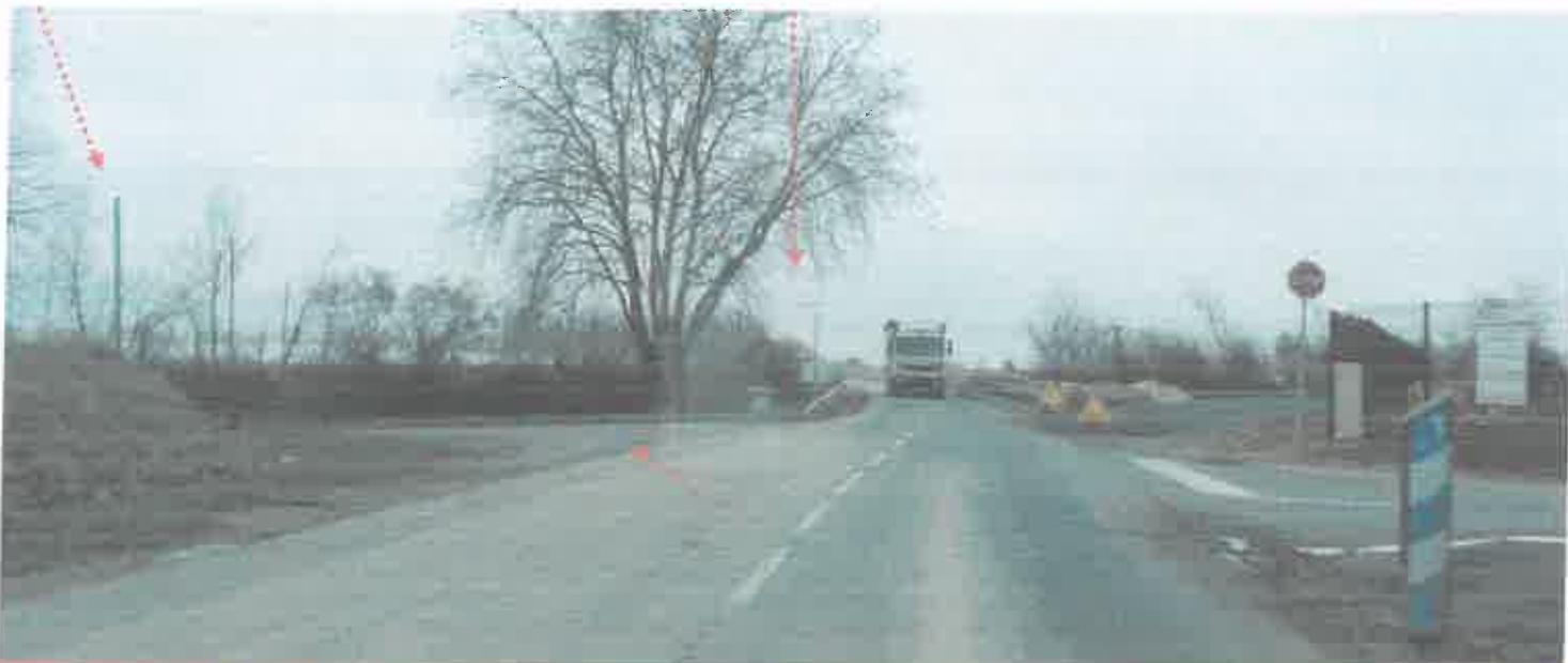
Les poids lourds mobilisent TOUTE la largeur du pont en légère courbe ; de plus le carrefour du centre de broyage n'est plus signalé , des poteaux ont perdu leurs panneaux , les marquages au sol ont disparu ; à noter aussi des arbres en surplomb des voies
