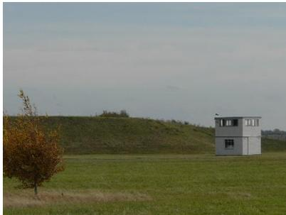
le paysage et la réduction du bruit des véhicules induits par les merlons, dont le dimensionnement est similaire à ceux prévus à Laon-Couvron : ils se sont rendus au pied et au sommet des merlons, monticules de terre végétalisés disposés le long de certaines pistes. Côté pistes, les merlons sont engazonnés, côté extérieur, ils sont plantés de haies et d'arbustes.
